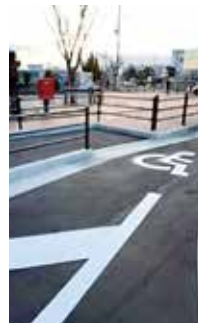
地下鉄八尾南駅の バリアフリー化
