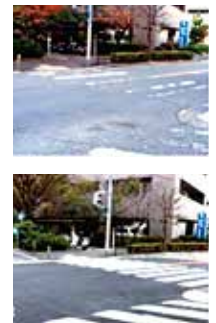
横断歩道の塗替え工事 上:工事前 下:工事後
